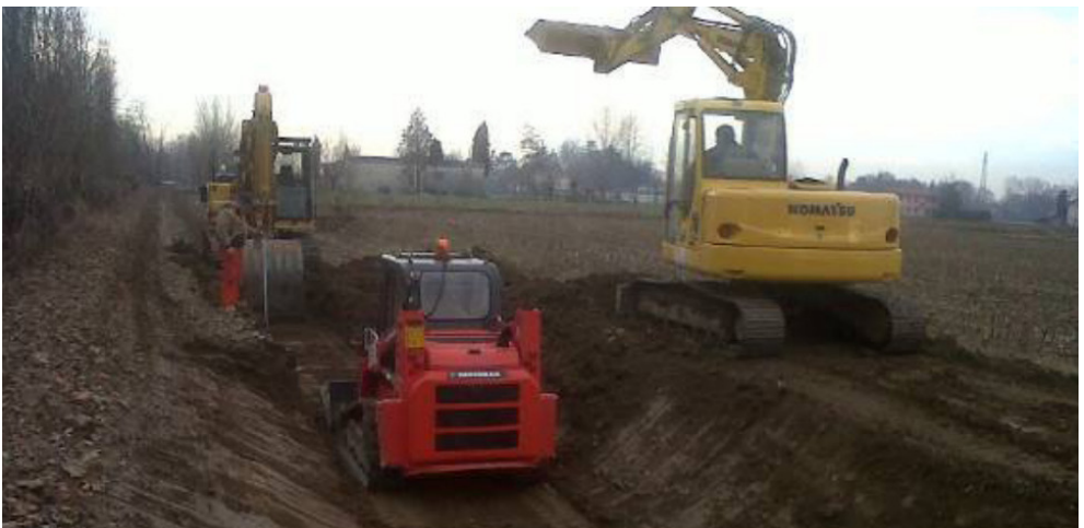
Figura 21 – Realizzazione di alcuni impianti di MAR nell'ambito del Progetto Life Aquor: pozzo di ricarica (alto), trincee di infiltrazione (centrale sinistra), roggia di infiltrazione (basso)
